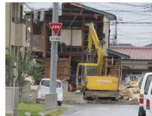
壊される住宅
